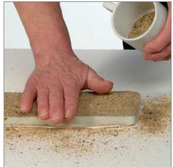
**Damit haben Sie den DoucheDrain außen rau gemacht, sodass eine gute und dauerhafte Haftung entsteht.**
